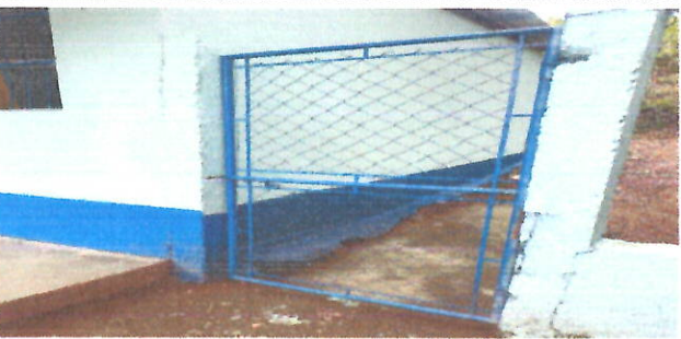
FOTO5: PUERTAS Suministro e instalación de puerta metálica, incluyendo chapa, bisagras.
