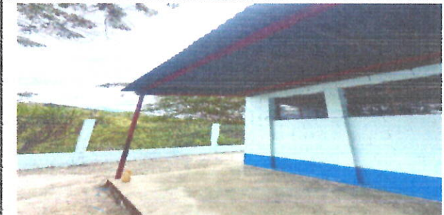
FOTO6: CUBIERTA DE LAMINA Sustitución de cubierta de techo con lámina galvanizada, Tipo de lámina: troquelada Calibre: 26, incluye: fijaciones y sellado en traslapes.
