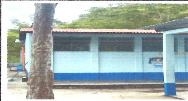
FOTO4: CUBIERTA DE LAMINA Sustitución de cubierta de techo con lámina galvanizada, Tipo de lámina troquelada Calibre 26, incluye fijaciones y sellado en traslapes.
