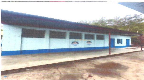
FOTO1: PINTURA EN MUROS INTERIOR Y EXTERIOR Preparación de la superficie y aplicación de pintura a dos manos, en paredes interiores y exteriores del establecimiento
