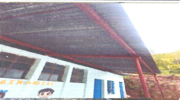
FOTO3: ESTRUCTURA DE TECHO Mantenimiento a estructura metálica existente retiro de óxido, suciedad y pintura deteriorada, incluye cepillado, lijado y aplicación de pintura
