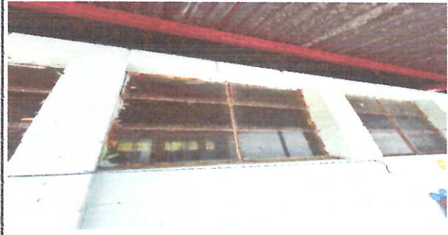
FOTO2: VENTANAS Sustitución de ventanas; sistema de apertura: Corredizas, Perfiles color blanco estandar, Material del marco: PVC Material de la ventana: Vidrio, sellado perimetral.
